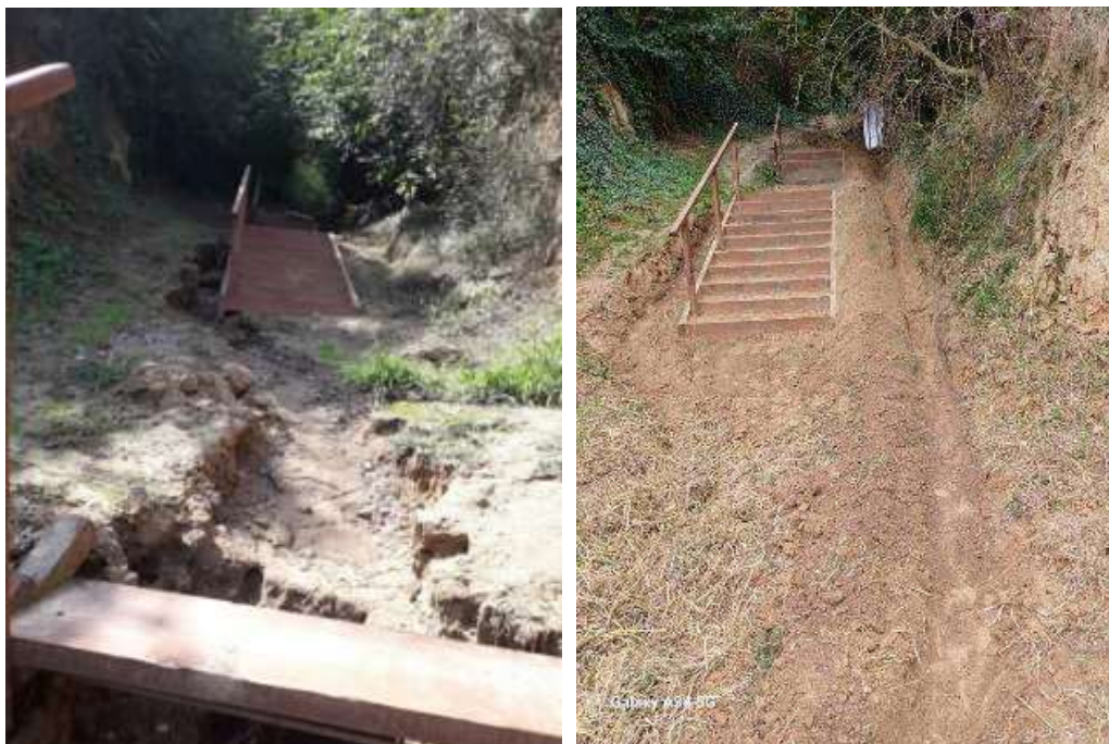
Слика 28а, 28б- Стрмина приступне стазе након бујичних вода пре и после санације
